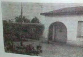
Sentel exterior de la Escuela Nº 5
